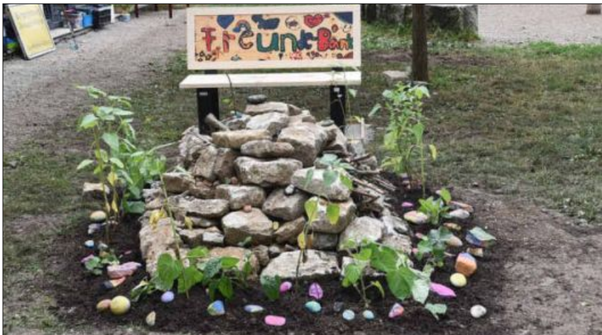
LINDENSCHULE WYHLEN: Fertig ist die Freundebank in der Lindenschule. Jetzt muss nur noch das Fundament trocknen.
