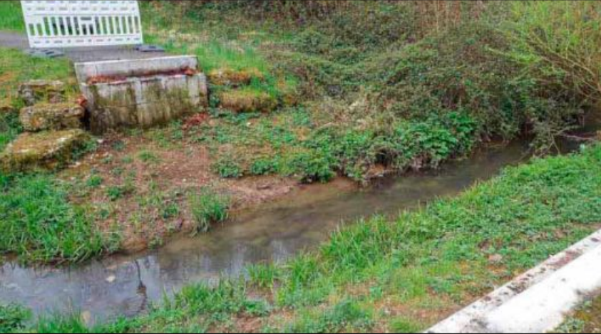
Auf halbem Weg nach Schwörstadt fehlt eine weitere Brücke über den Bachtelengraben.
